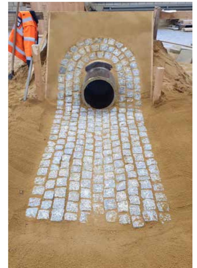
Schachtmauerwerk im Reihenverband mit Kanalrohr und Rollschicht von Noah Topp (Tiefbaufacharbeiter 2. Lehrjahr)
