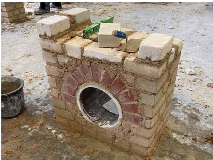
Schachtmauerwerk im Reihenverband mit Kanalrohr und Rollschicht von Noah Bittag (Tiefbaufacharbeiter 2. Lehrjahr)
