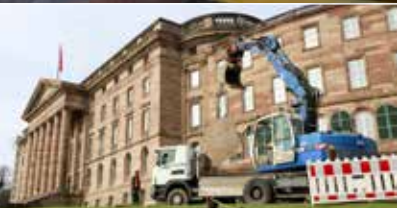
Kanalsanierung Bergpark Kassel
