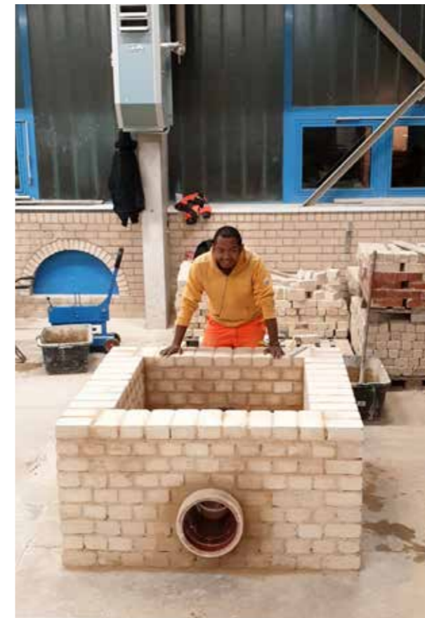
Schachtbauwerk in Binderverband von Manajaso Telina Razafimampanana (Kanalbauer 3. Lehrjahr)
