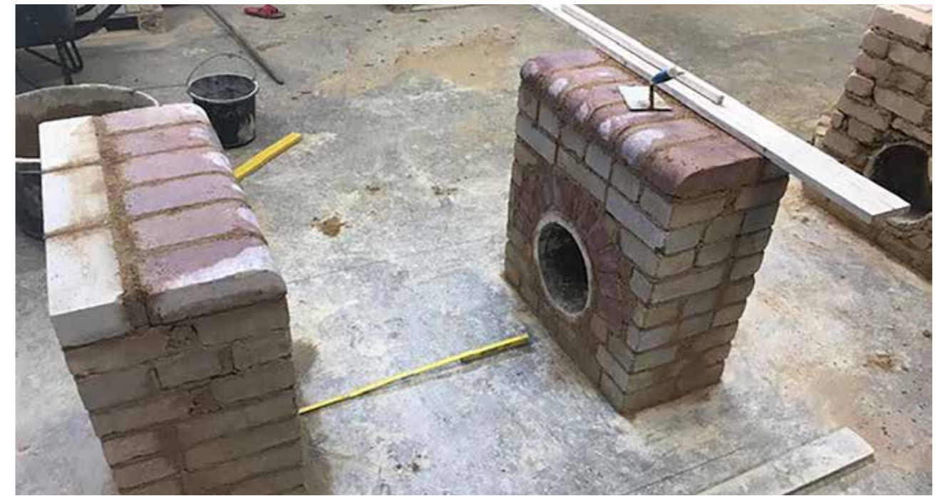
Rohrauslass mit Gerinne in Reihenverband von Manajaso Telina Razafimampanana (Kanalbauer 3. Lehrjahr)
