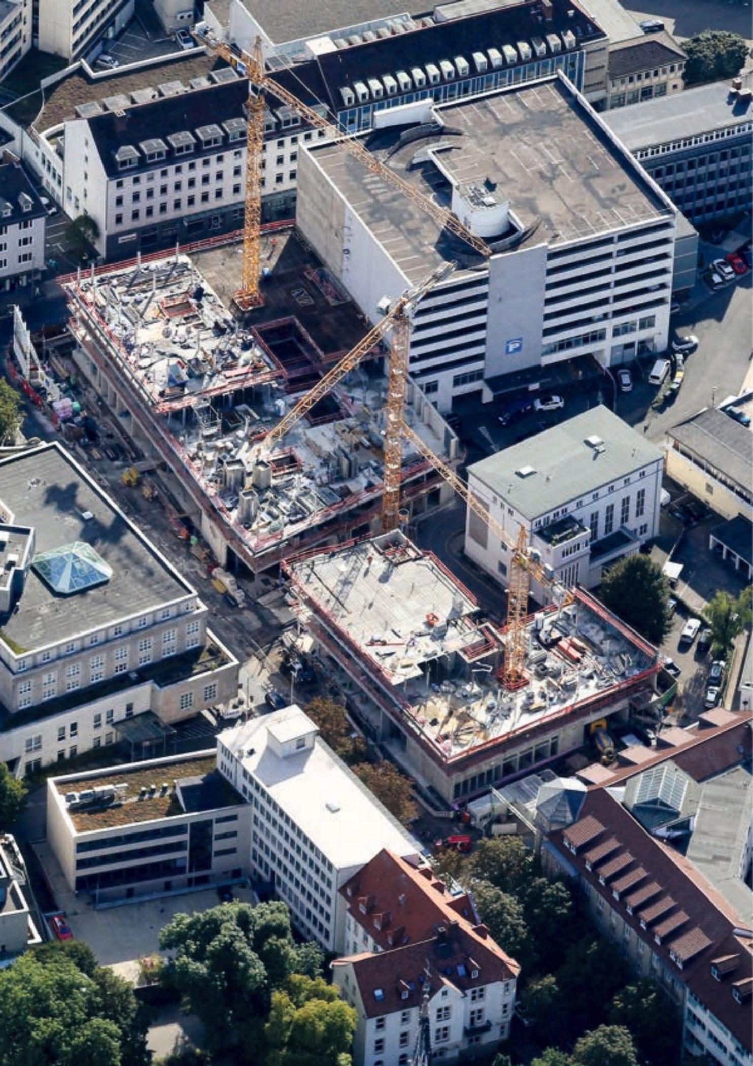
Im Berichtsjahr 2022 haben wir dann rund 12.000 m³ Beton bis zur Festigkeitsklasse C50/60 sowie 2.200 t Betonstahl in über 40.000 m² Schalung eingebaut. Die Bodenplatte „verschlang“ davon allein beachtliche 3.700 m³ Transportbeton. Bei einem Mischerinhalt von 8 m³ sind das allein schon über 460 Lkw-Ladungen!
