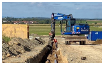
Verlegung Trinkwasserleitungen Reinheim RTE
